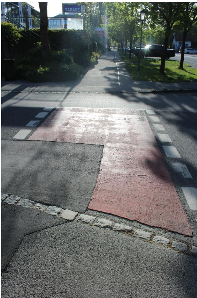
Abbildung 3: Partielle Rotmarkierung einer Radfurt – Am Schloßbühl / Am alten Bahnhof
