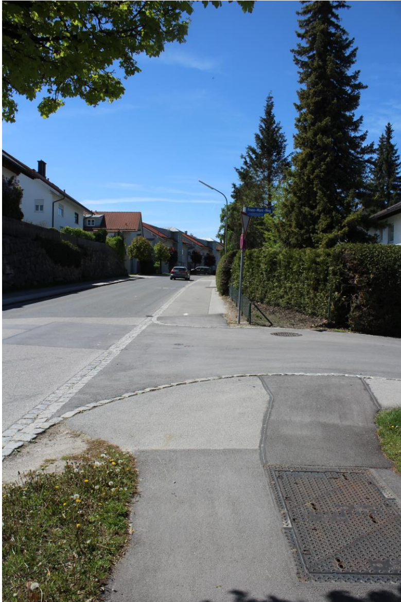
Abbildung 5: Kreuzung ohne Furtmarkierung nach Baumaßnahmen – Sindelsdorfer Straße
